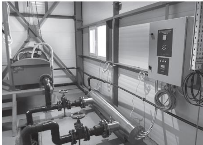
Рис. 2. Установка УФ знезараження води ВОДОГРАЙ В40.01 (очисні споруди пгт Очеретівка, Донецька обл.)
