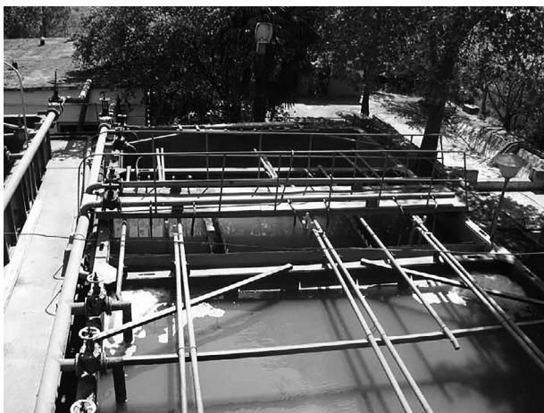
Рис. 1. Компактная блочно-модульная установка МОКСА-70 производительностью 70 м 3 /сутки.
